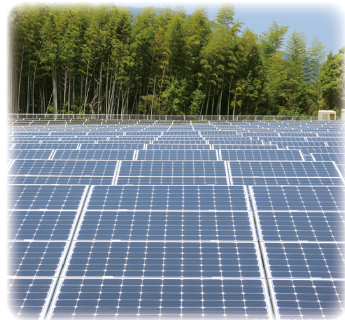
▲完成した「神在太陽光発電所」
