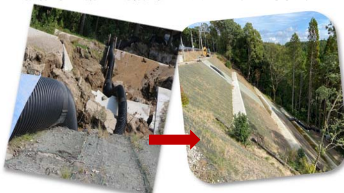
2回の豪雨の影響を受けて決壊した発電所内の法面の補修が完了！むき出しだった排水管を地中に埋設。
