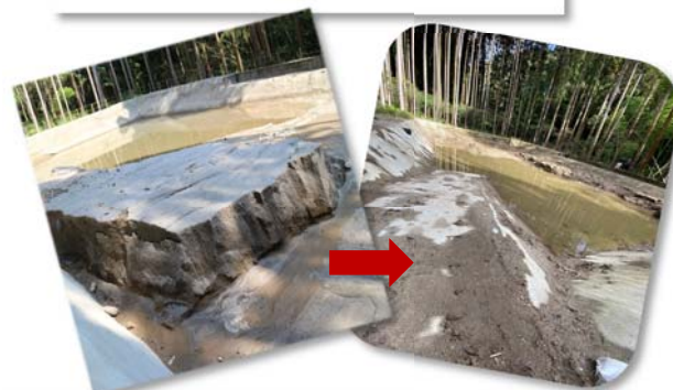
沈砂池に溜った大量の土砂のかき出し作業中。
