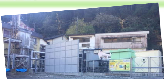
周辺に迷惑がかからないよう防音壁を設置しました
