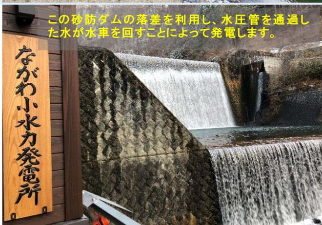
この砂防ダムの落差を利用し、水圧管を通過した水が水車を回すことによって発電します。
