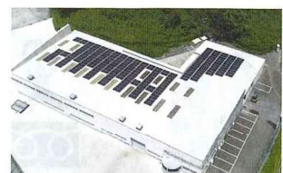
TMRセンター発電所
