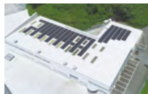
TMRセンター発電所
